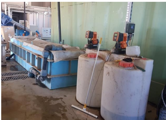
Фото 10. Реакционная камера и реагентное хоз-во для конечной коррекции pH
